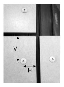
THE DISTANCE FROM THE FIXINGS TO THE PANEL EDGE MUST NOT BE TOO SMALL TO AVOID EDGE BREAKAGE
