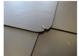
Pose de l'ardoise en losange dans le crochet.
