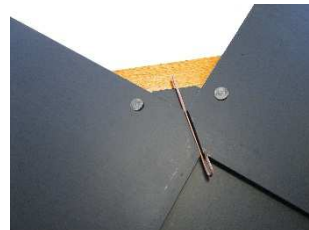
Clouage dans la latte et pose du crochet dans le joint entre 2 ardoises.
