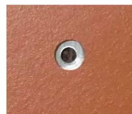
Entfernen Sie sämtliche Bohrverschmutzungen sofort mit einem weichen, sauberen und trockenen Tuch oder einer Bürste.
