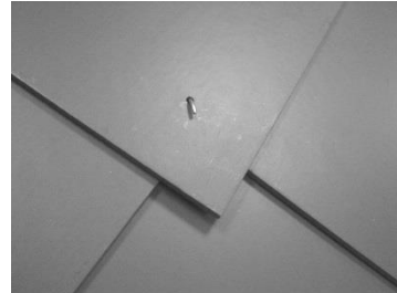
Folgende Platte befestigen über der Plattenklammer und die Klammer nach unten biegen; nicht zu fest so das Bewegung von der Platte möglich ist.
