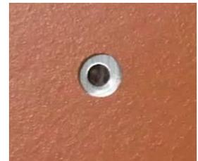
Entfernen Sie sämtliche Bohrverschmutzungen sofort mit einem weichen, sauberen und trockenen Tuch oder einer Bürste.
